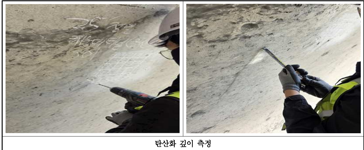
【사진 8.4.2】 탄산화 깊이 시험 현장사진
