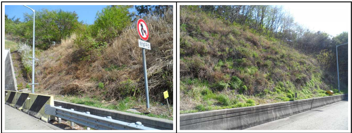
【사진 8.3.9】 사면 전경
