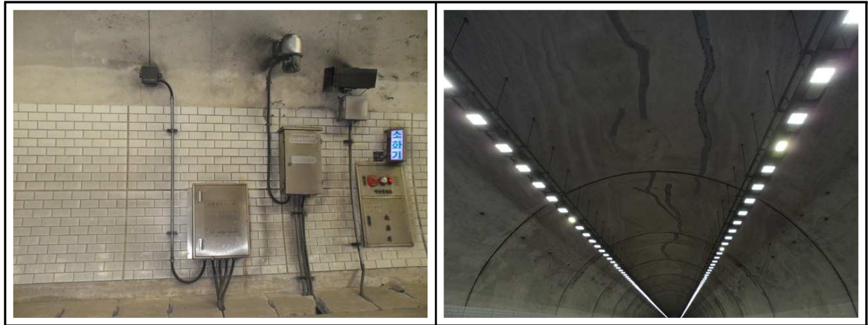
【사진 8.3.17】 기타부속시설 전경
